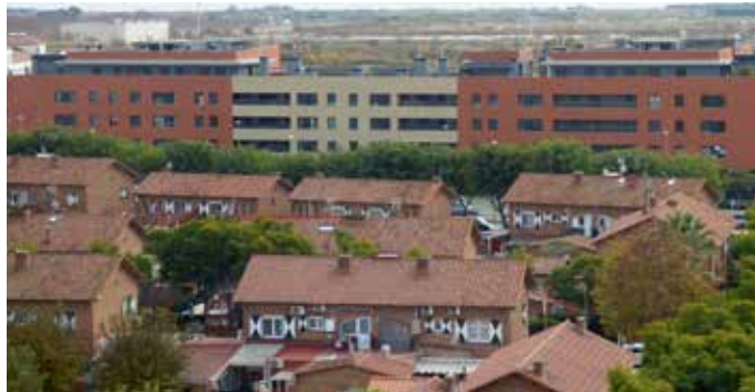
Pisos a la zona sud del Prat / ARXIU DELTA
