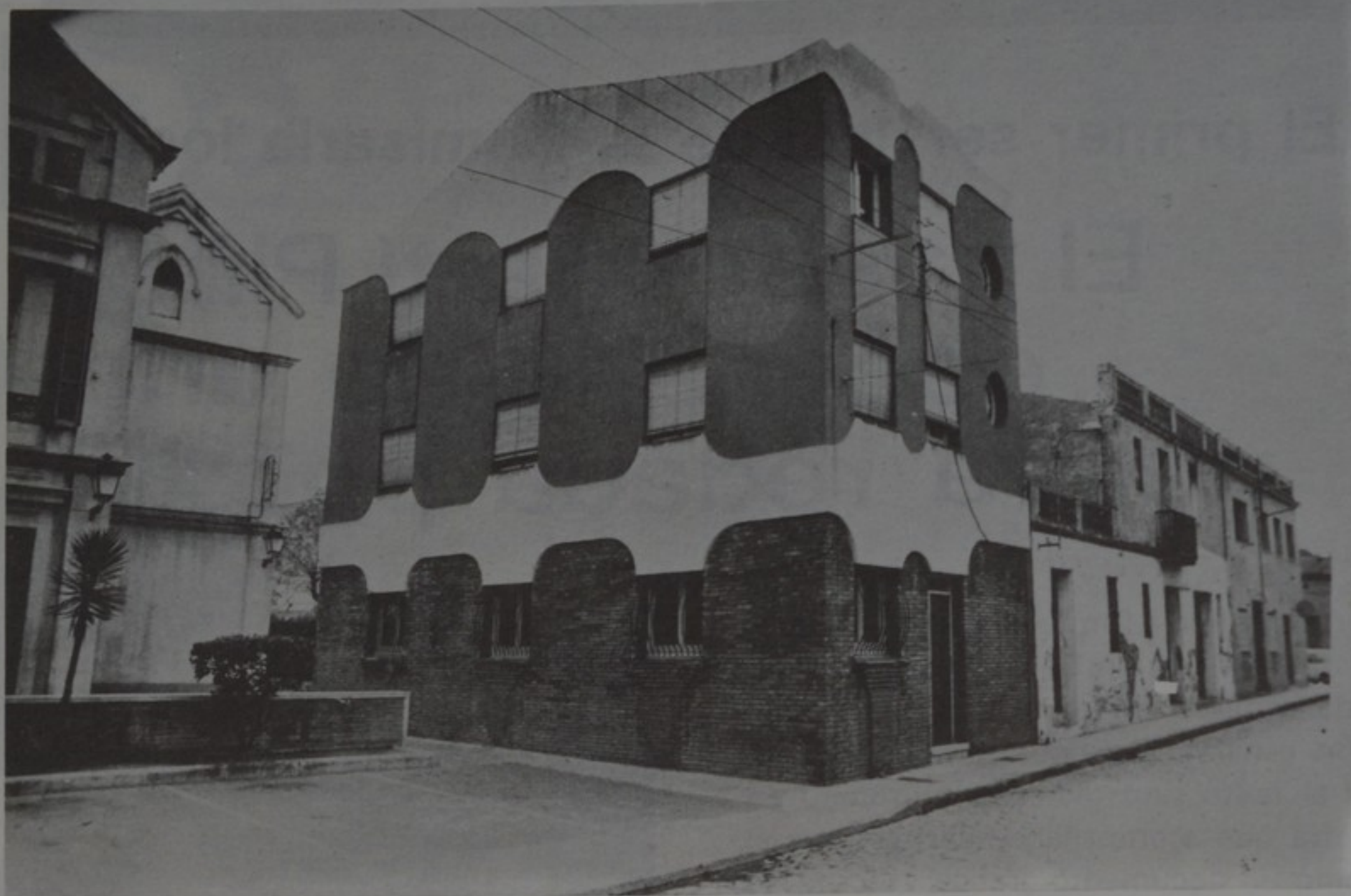
En el que fue edificio de la Delegación de Juventudes ha quedado instalada la nueva Comisaría de Policía
