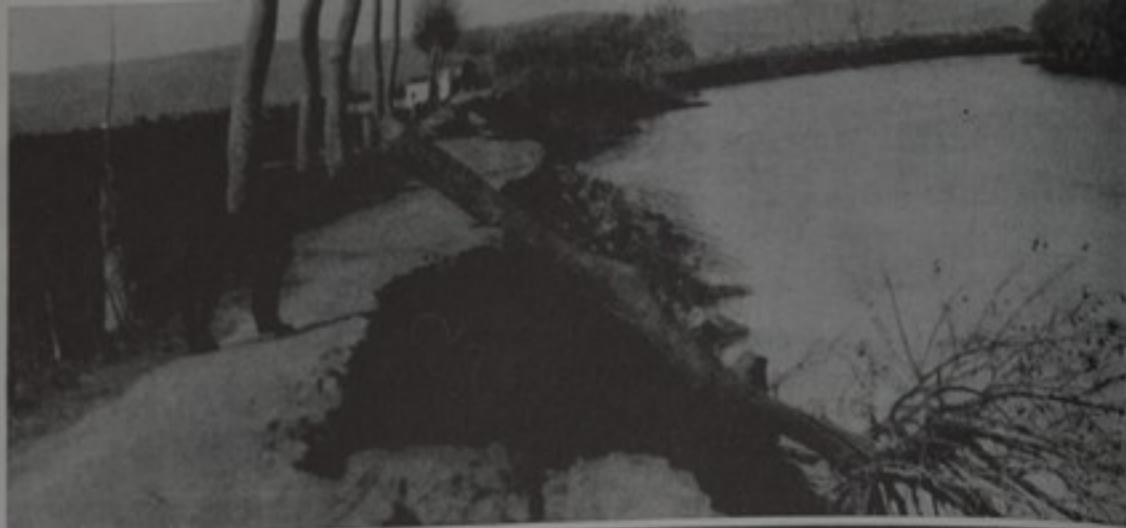
En la foto superior puede observarse la repercusión de una riada en una de las orillas del cauce. Precisamente es el punto donde en las condiciones actuales podría producirse la rotura de márgenes que comentamos en este artículo.
