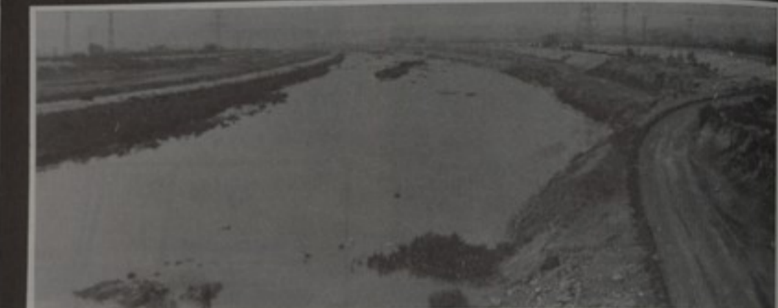
En la foto superior puede observarse la repercusión de una riada en una de las orillas del cauce. Precisamente es el punto donde en las condiciones actuales podría producirse la rotura de márgenes que comentamos en este artículo.
