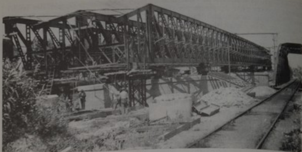
— Treballs de construcció de l'actual pont damunt el Llobregat. A la dreta es pot contemplar un dels ponts de "les tres puntes" que fou traslladat provisionalment i que quedà en servei el 3 de març del 1939.
