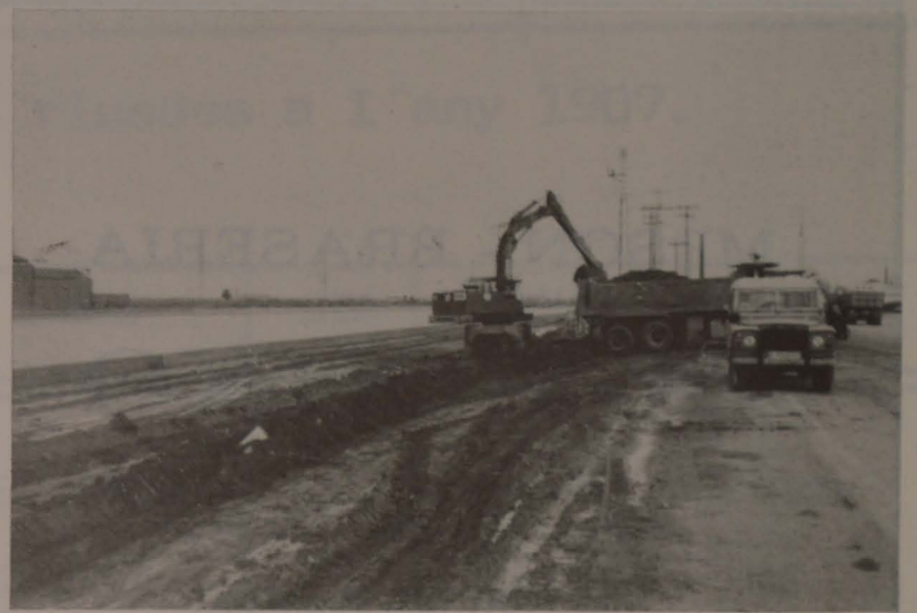
Treien terra del riu per a reforçar el marge
