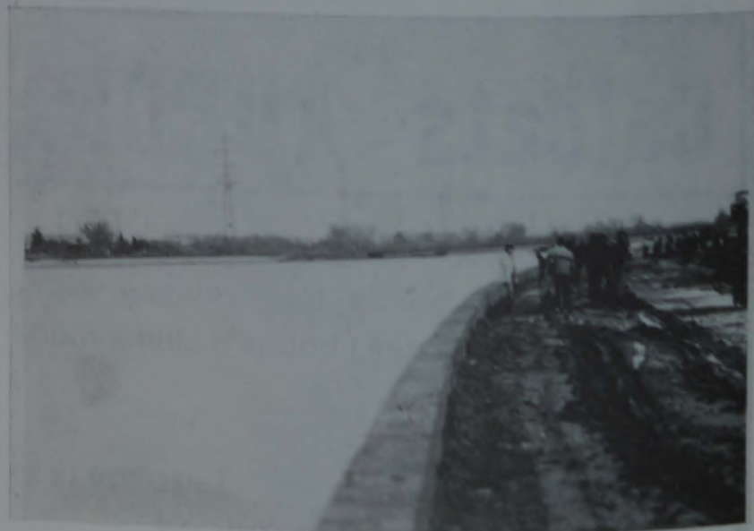
En certs indrets la canalització va funcionar
