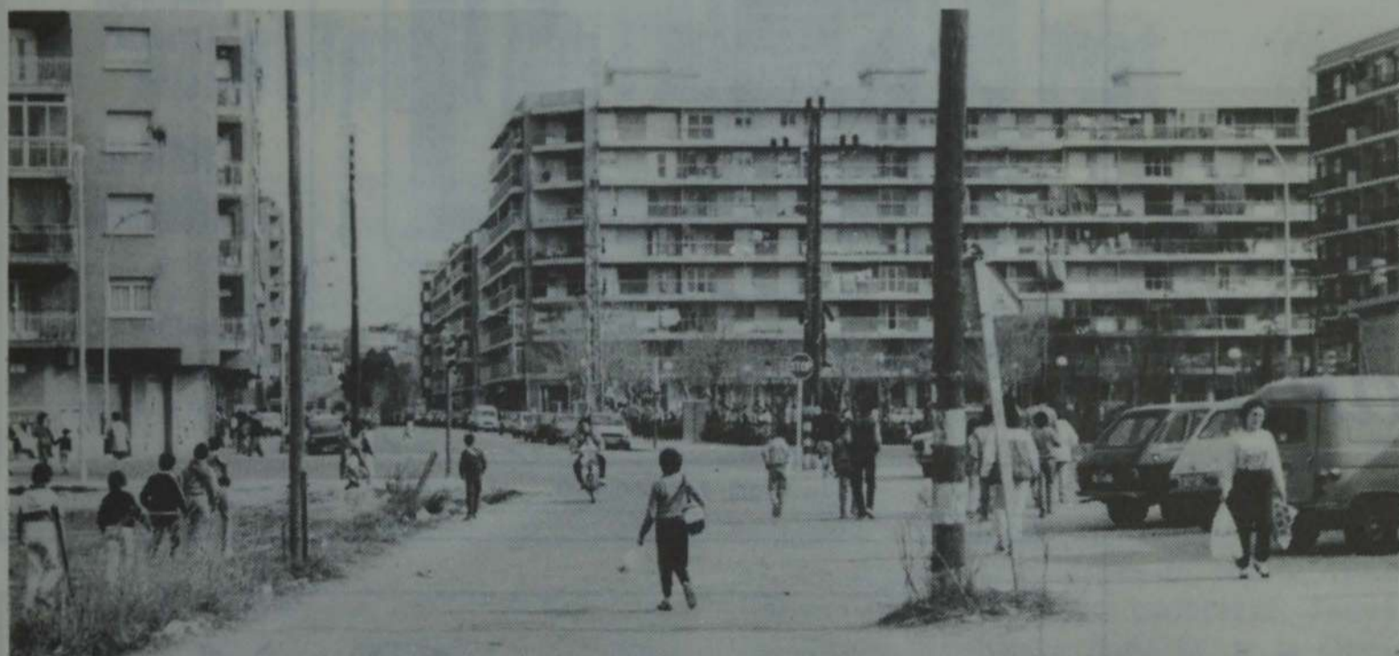
Avinguda Pompeu Fabra. Los vecinos esperan su urbanización definitiva. Mientras, los postes que sostienen cables de alta tensión entorpecen la normal circulación de vehículos y peatones.
