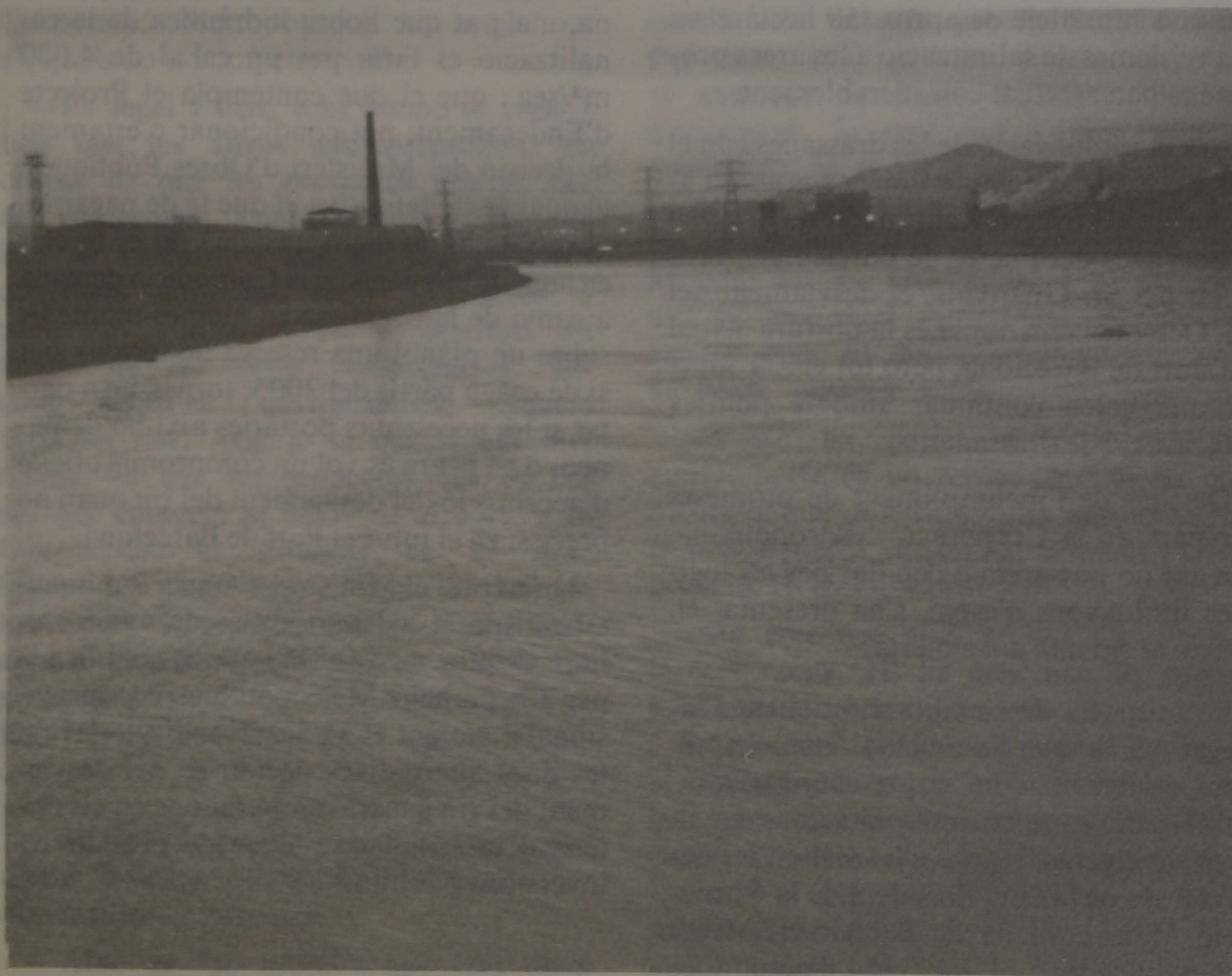
La canalització va evitar que la riuada del 8 de novembre del 82 inundés el casc urbà.
