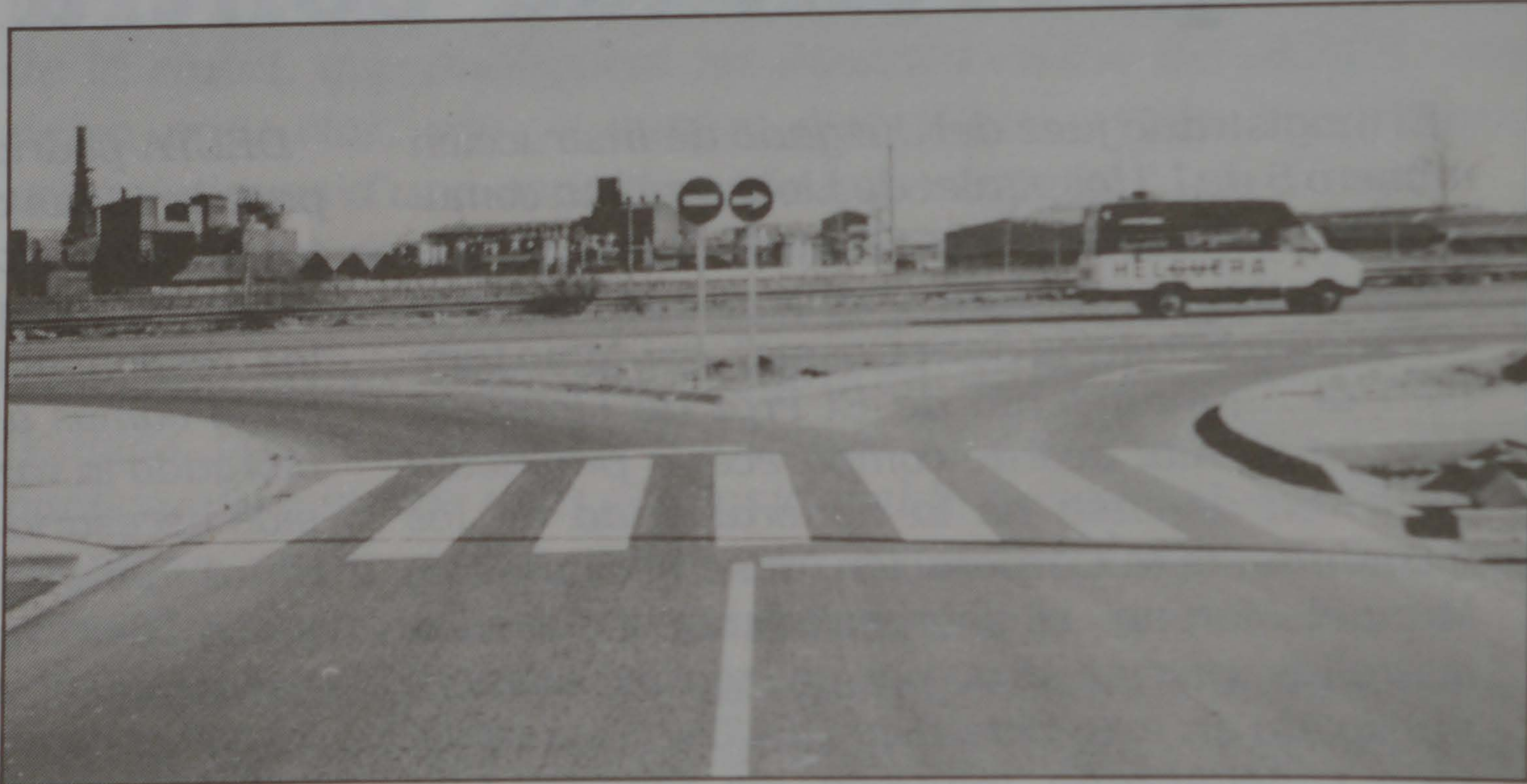
No hay posibilidad de acceder directamente a la carretera de Mercabarna desde la Avenida Verge de Montserrat.
