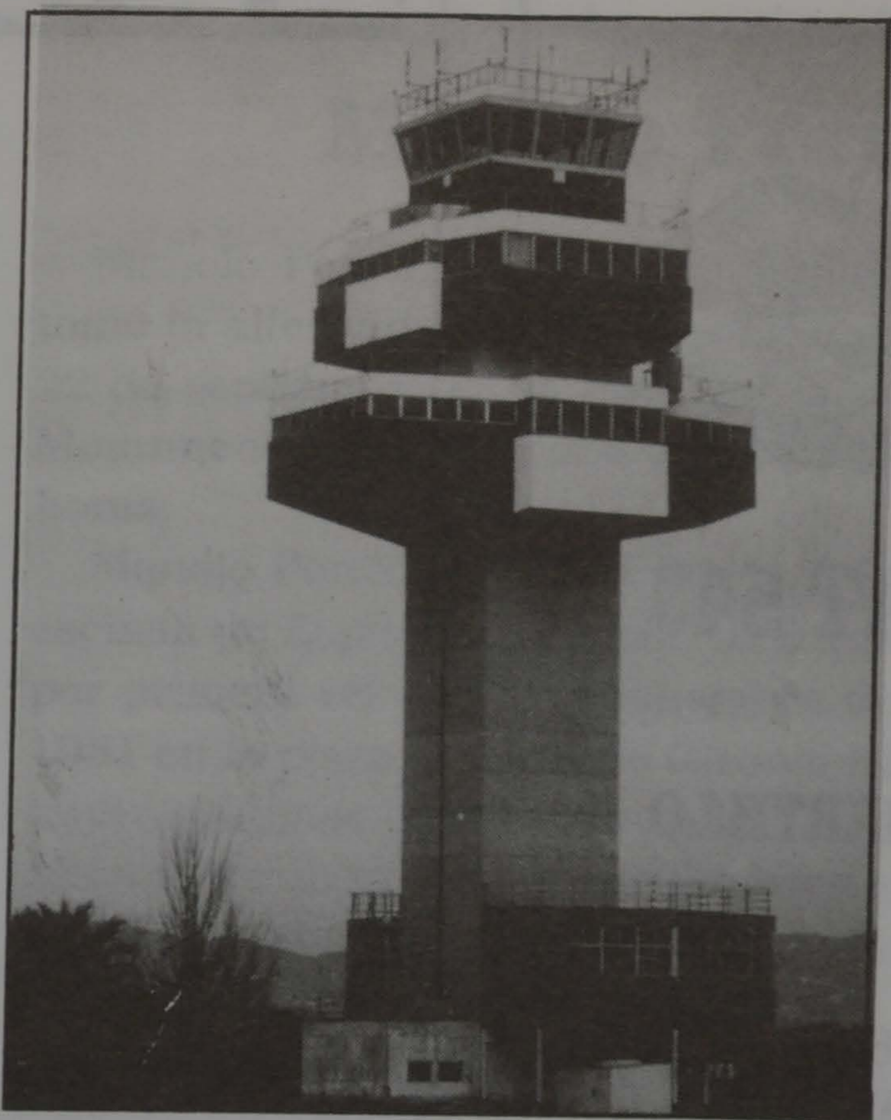
Torre de control del aeropuerto del Prat
