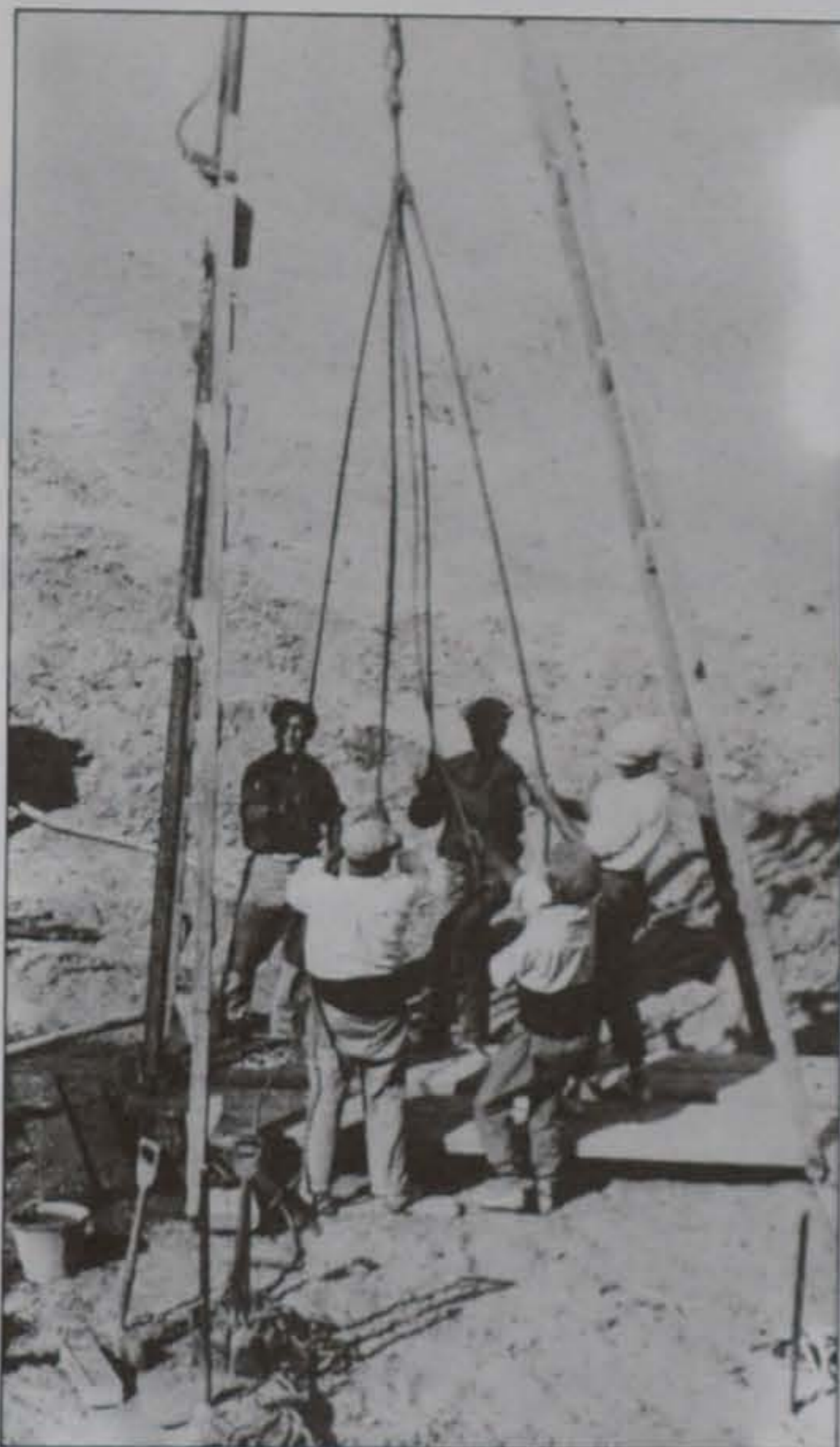
Detall dels treballs de perforació dels primitius pous artesianos
