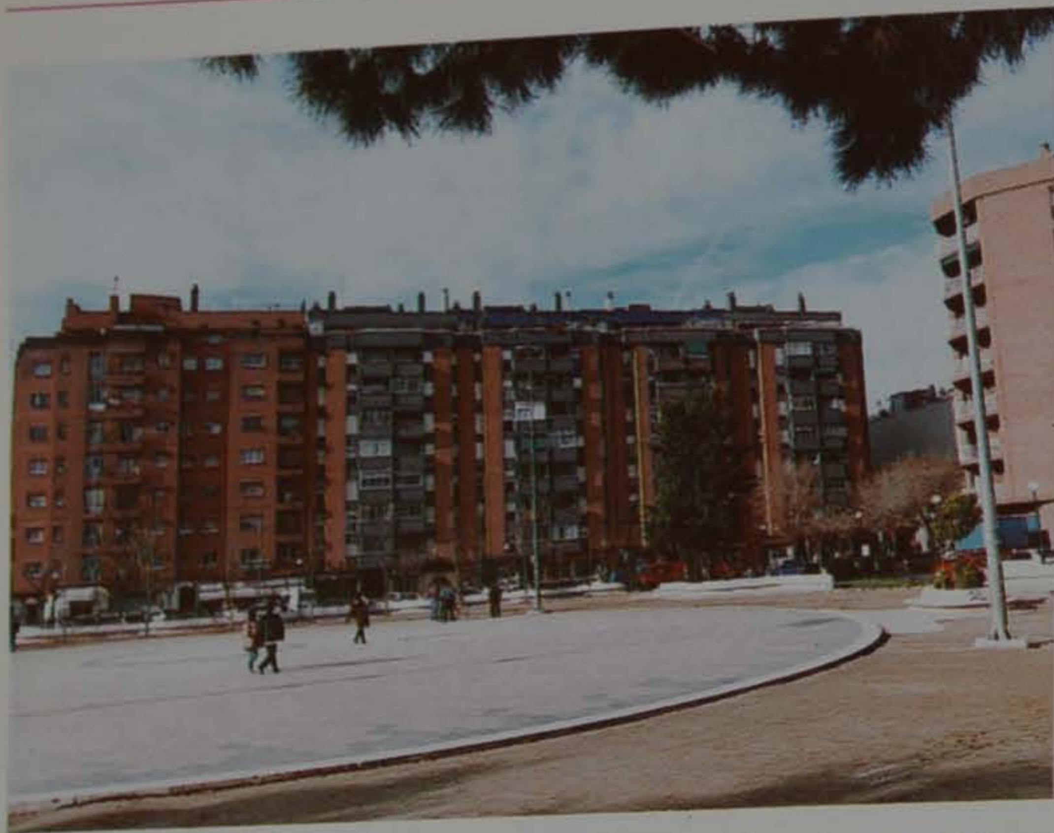
Construiremos en el subsuelo de Plaza Catalunya el 1er parking público de El Prat.
