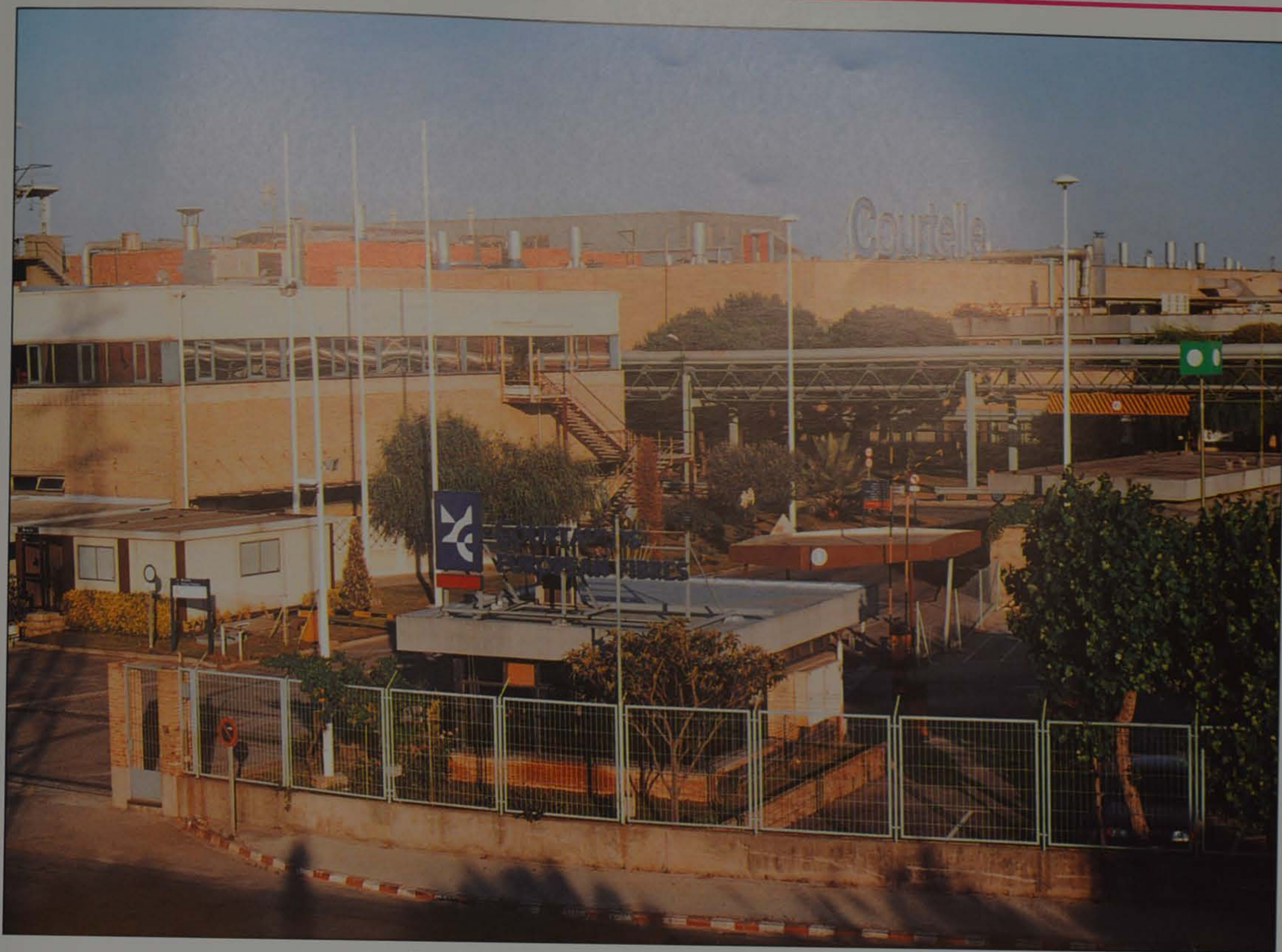
Instalaciones de Courtauld's España S.A. en El Prat
