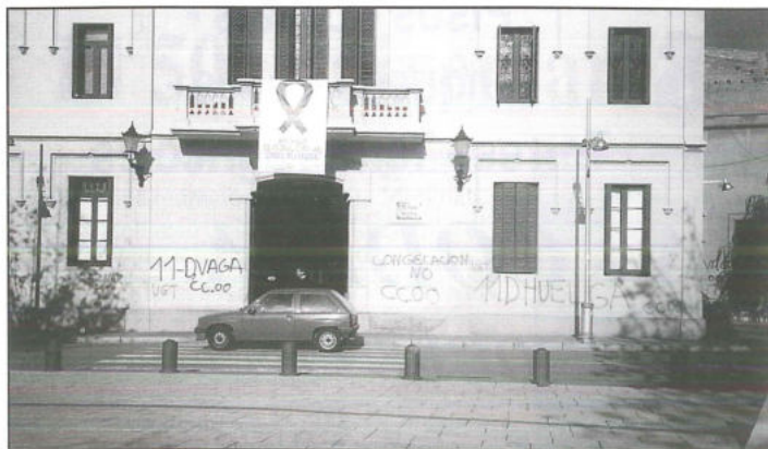
Aspecte de la façana de la Casa de la Vila
