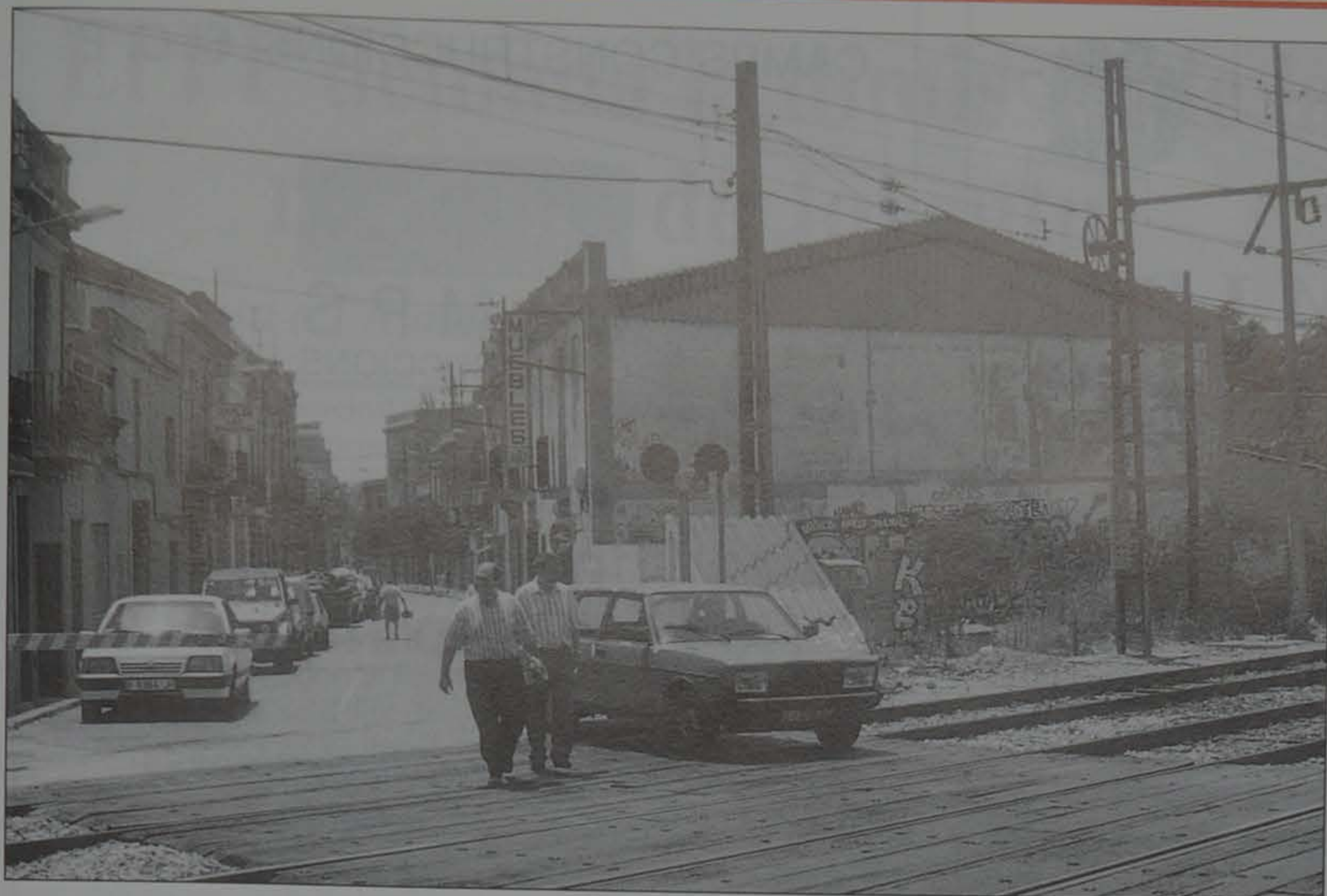
Pas a nivell amb barreres del carrer Major
