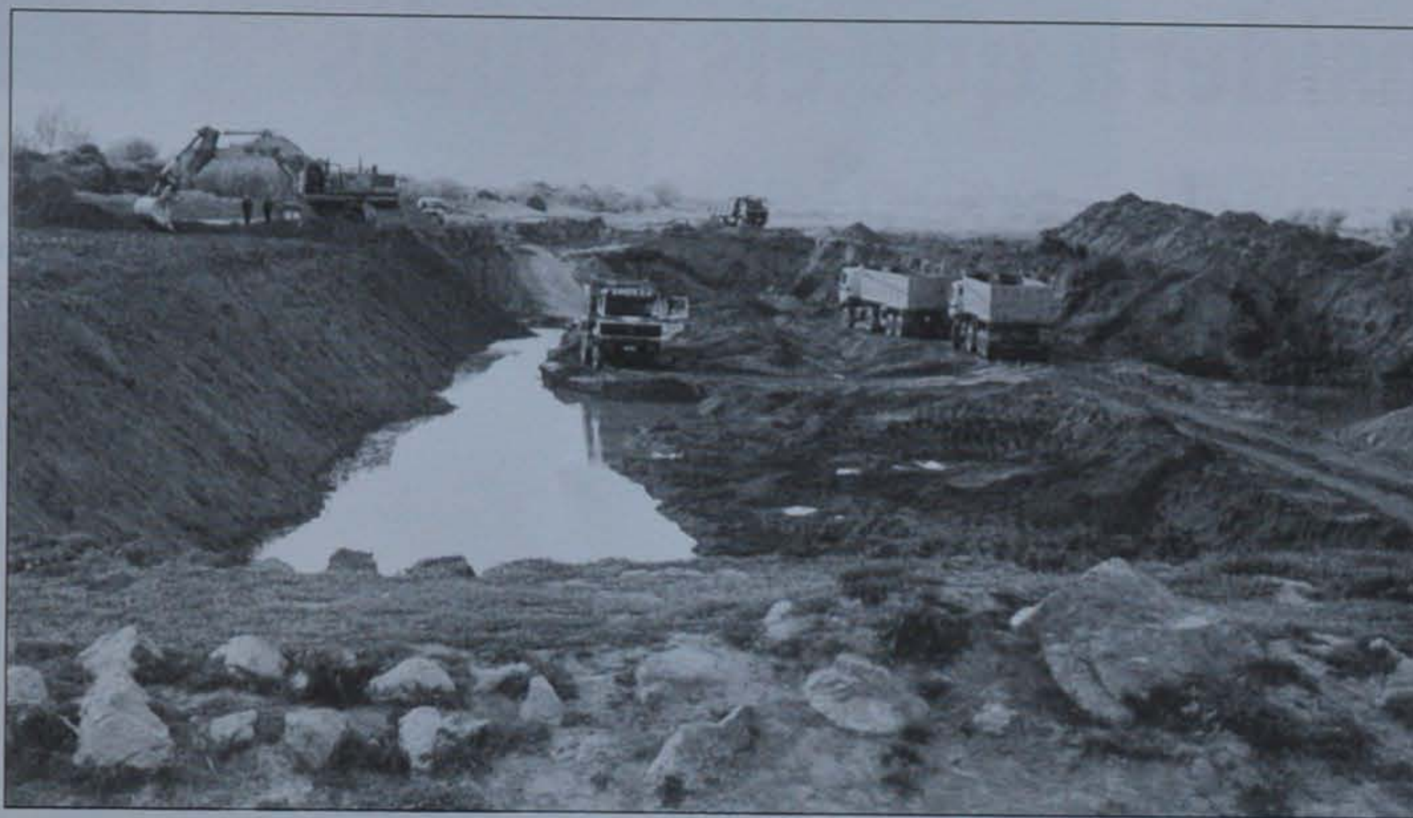
Excavació d'àrids en la llera del riu Llobregat, sota el nivell de l'aquífer (foto: J. Ferret)
