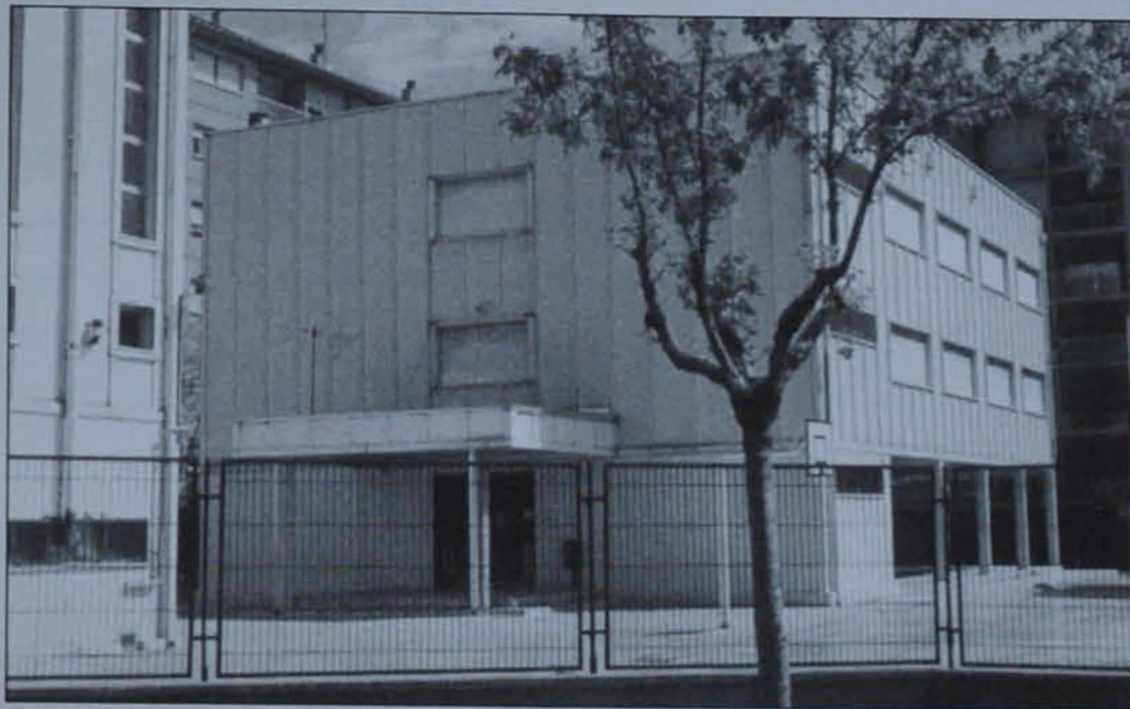
L'Associació de Pares lamenta l'enderrocament de l'escola
