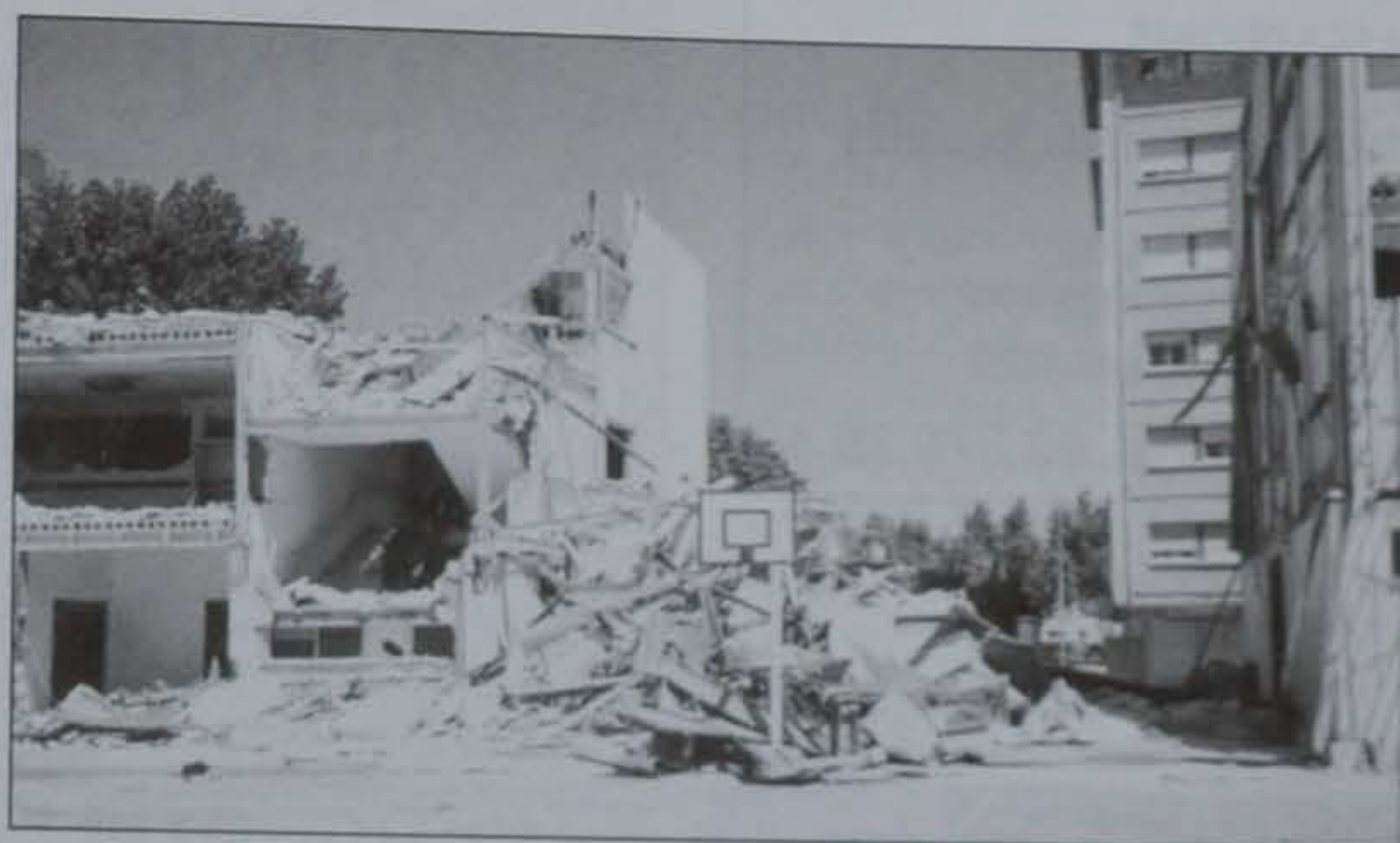
Les obres d'enderrocament de La Granja van començar a principis del mes de juliol i al seu lloc es farà una zona verda
