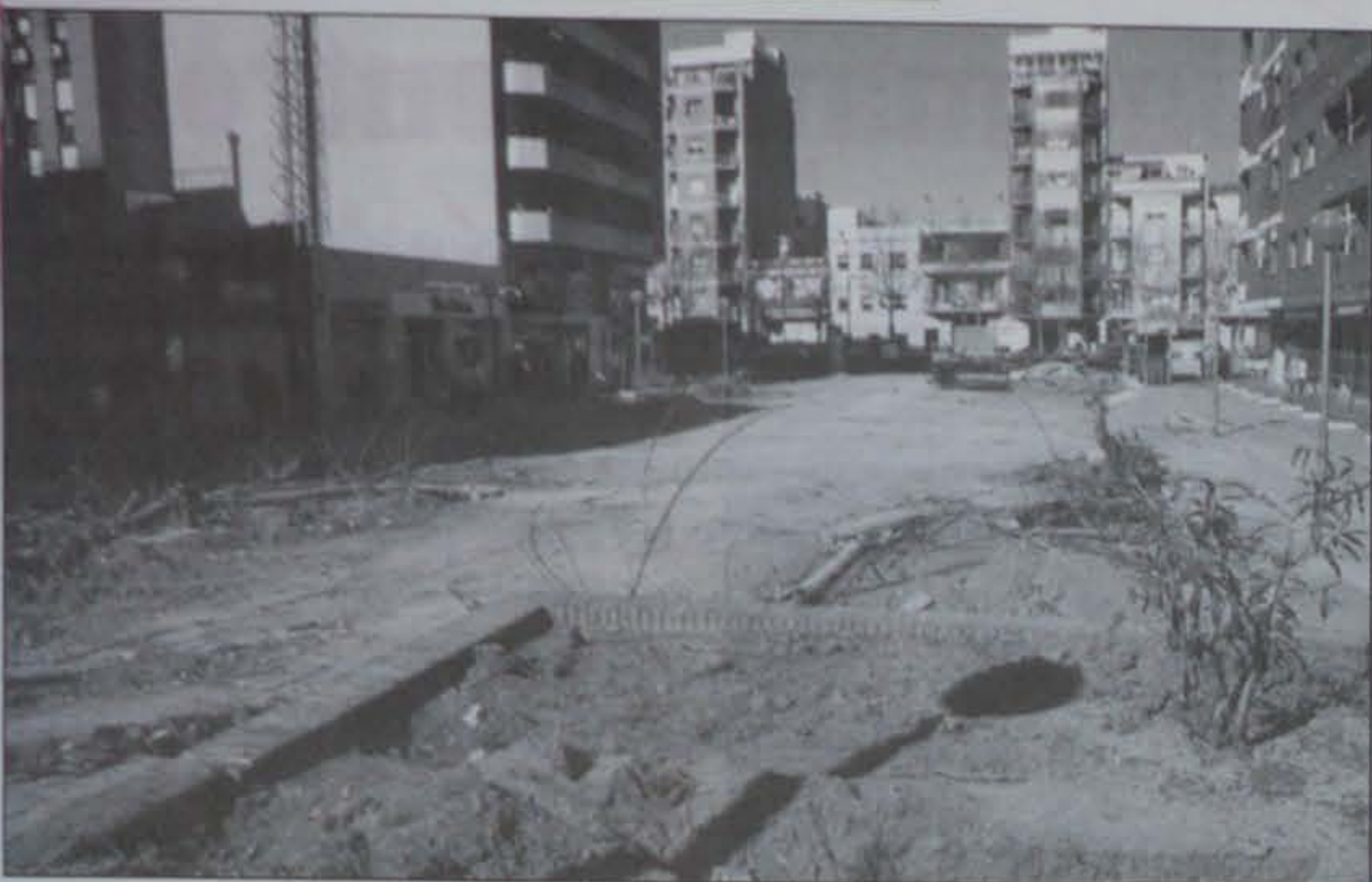
Aspecte de les obres a Gallart i Monés
