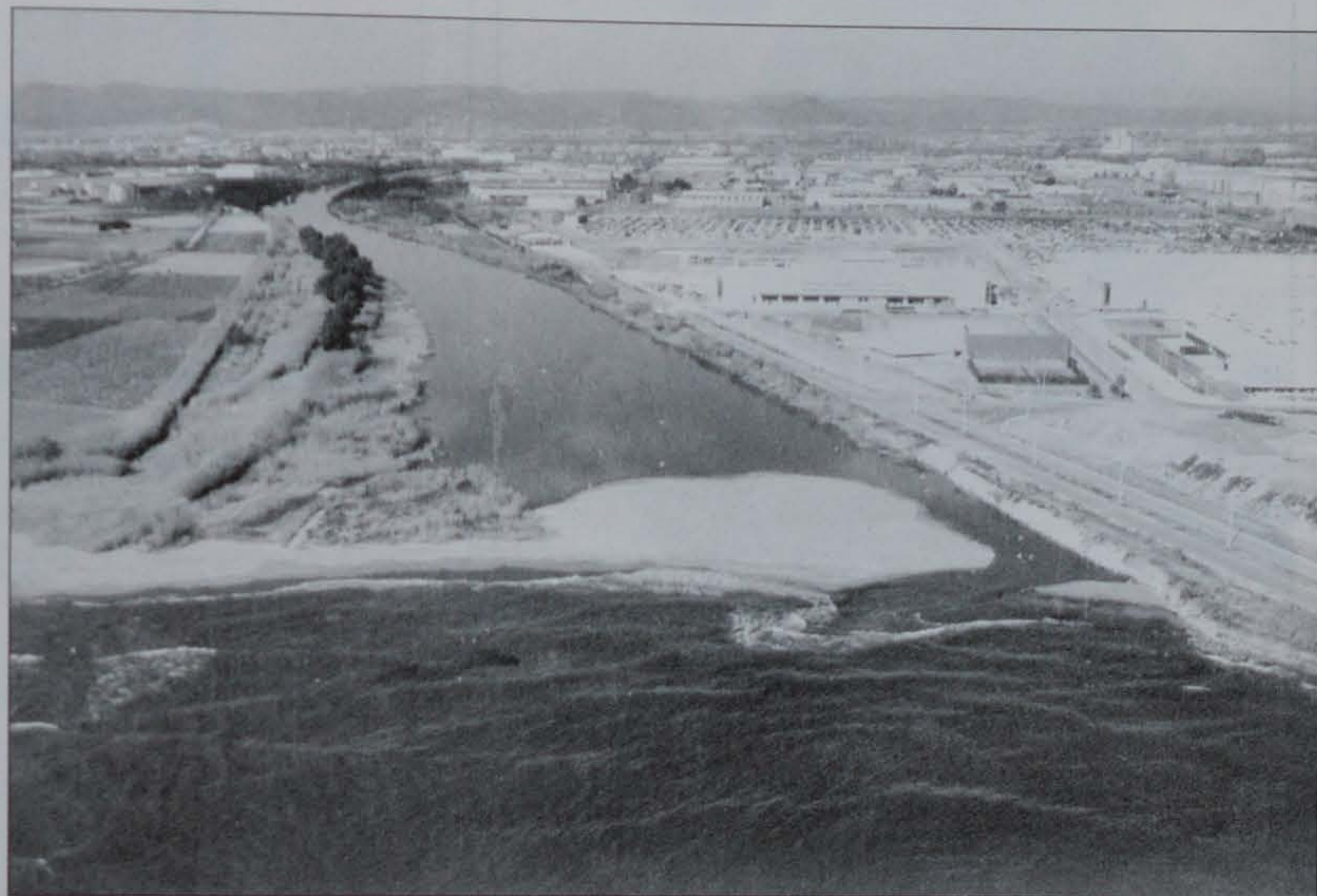
El desviament del riu permetrà la construcció de la depuradora del Baix Llobregat
