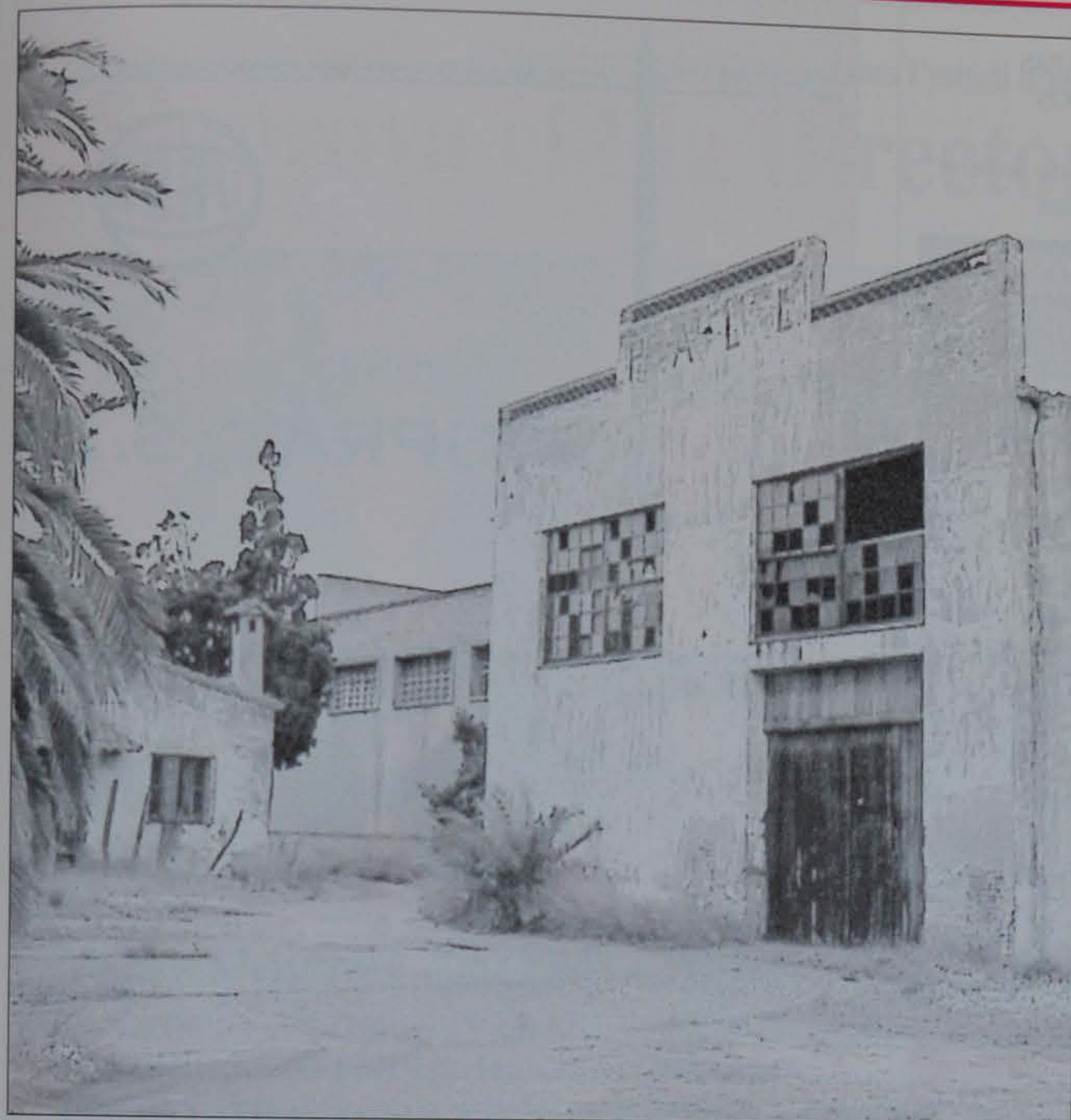
Façana del magatzem on hi ha instal·lat el molí d'arròs
