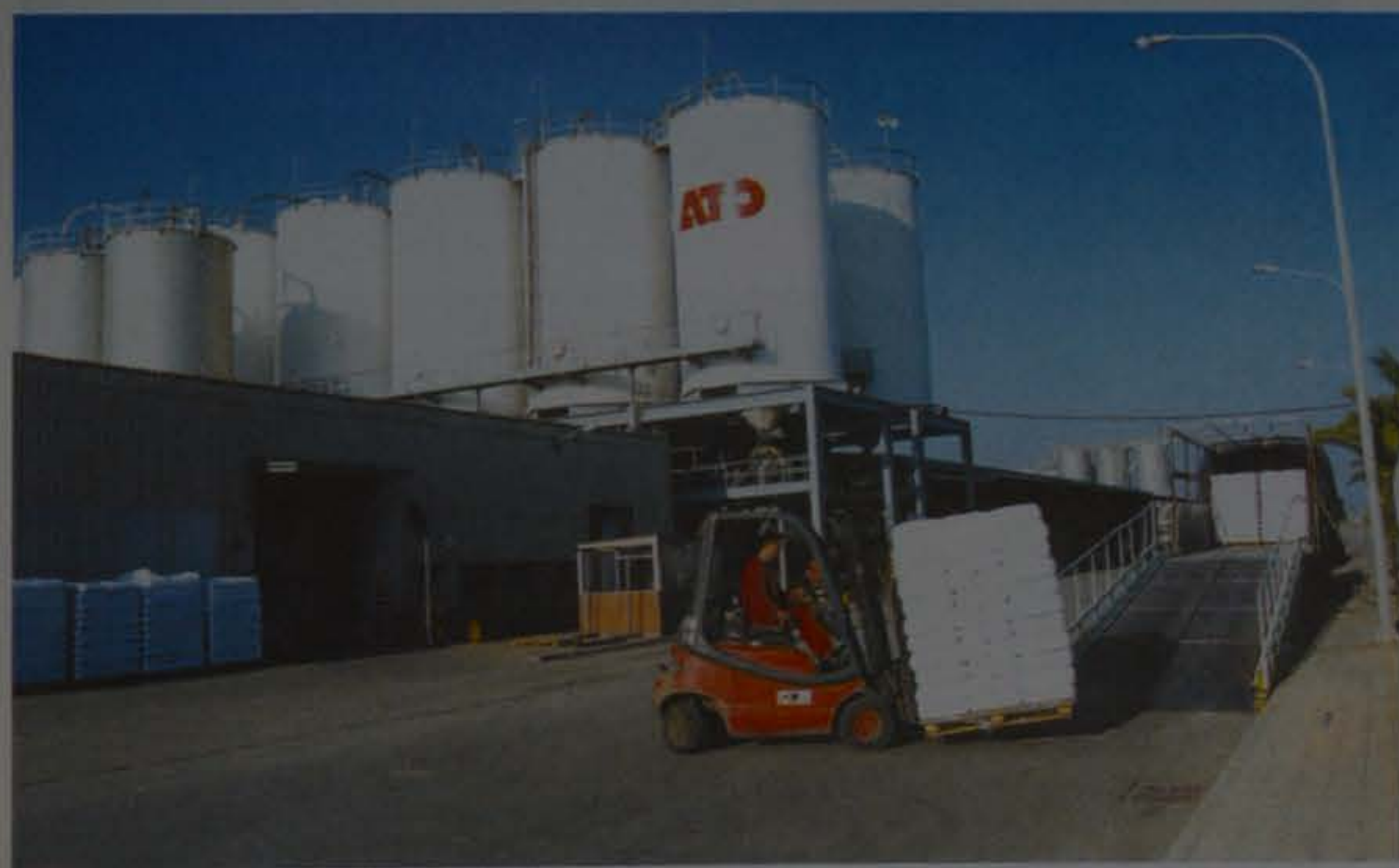
Vista de los silos de almacenaje de poliestireno en la planta de Elf Atochem en El Prat
