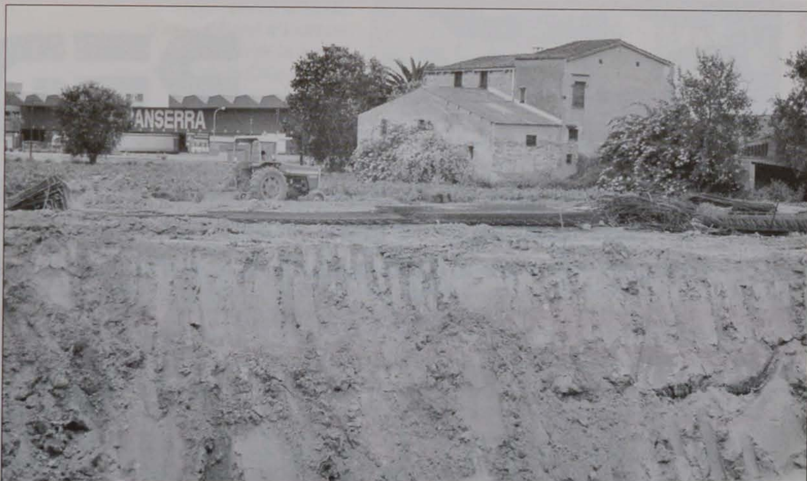
Els agricultors del voltant de Cal Bitxot segueixen llaurant els camps, tot i tenir les obres del col·lector gairebé al damunt
