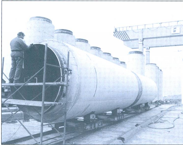
Secció d'un dels col·lectors de la depuradora
