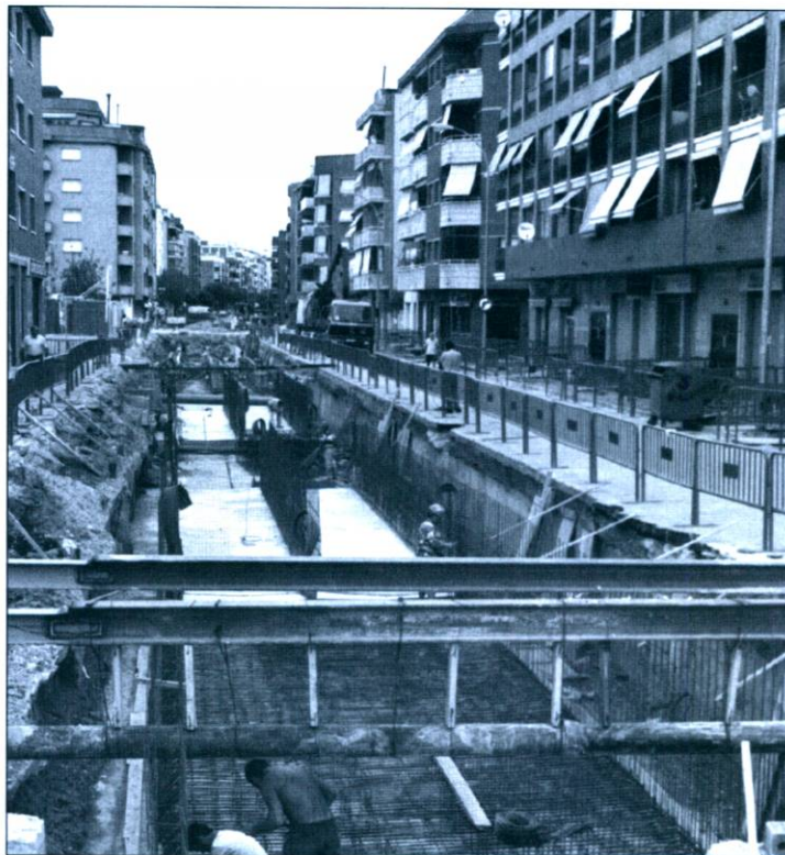
La instalación del colector exige la perforación de la calle
