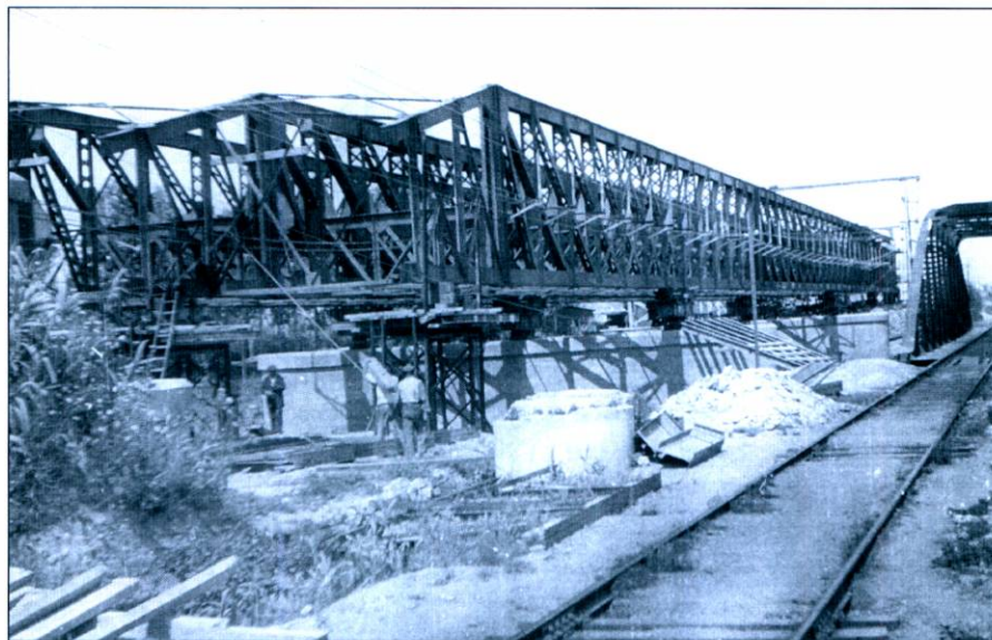
Treballs de muntatge del nou pont del ferrocarril a la primavera del 1941
