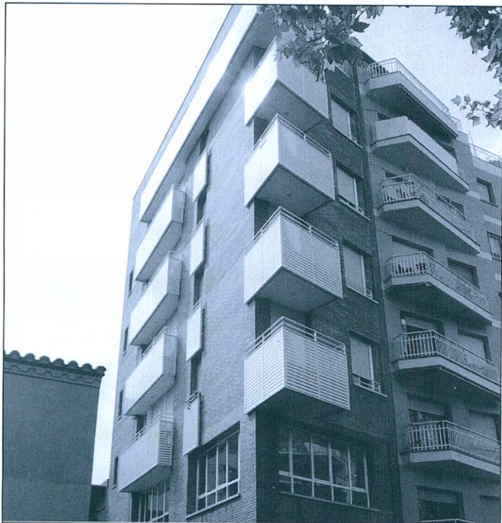
La reforma de les Cases d'en Puig va permetre aixecar aquest edifici
