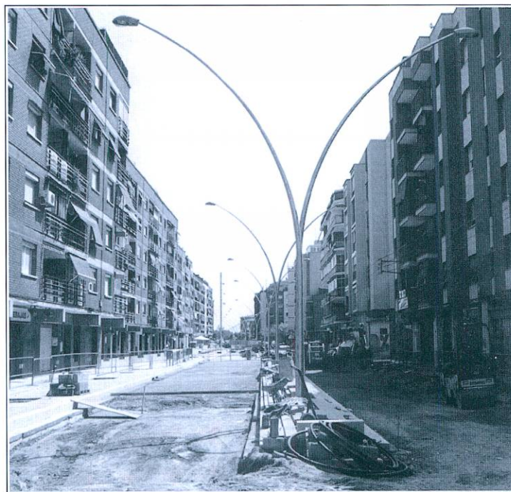
La Carretera de la Marina renova un altre tram
