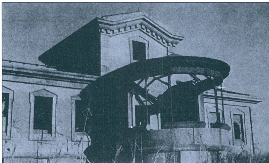
Detall del semàfor, on es pot contemplar l'estructura de ferro del mirador
