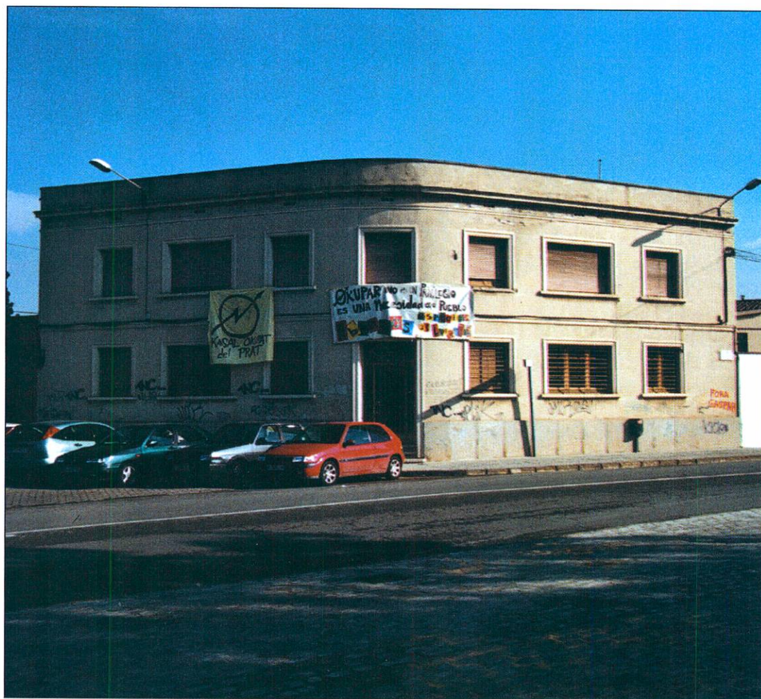
Les instal·lacions de l'antiga hidroelèctrica, amb una pancarta a favor de l'okupació, van ser netejades el passat 1 de febrer en una convocatòria que va fer el col·lectiu de joves
