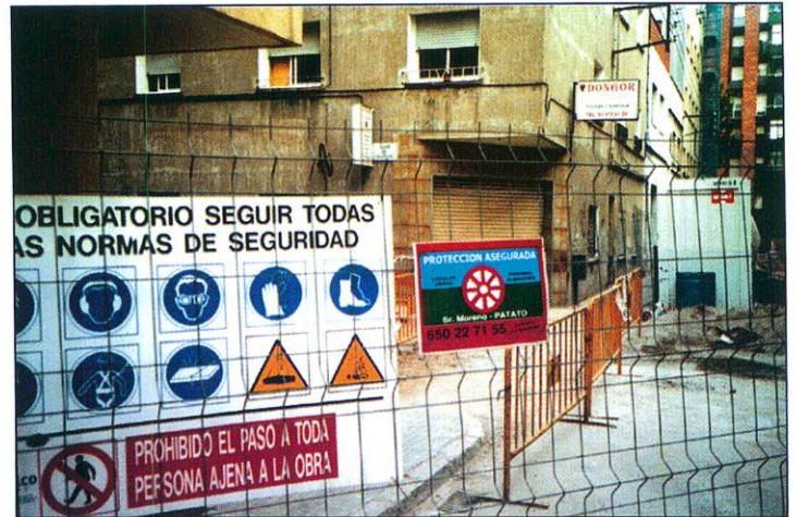
La rueda de carro hace las veces de vigilante de obras
