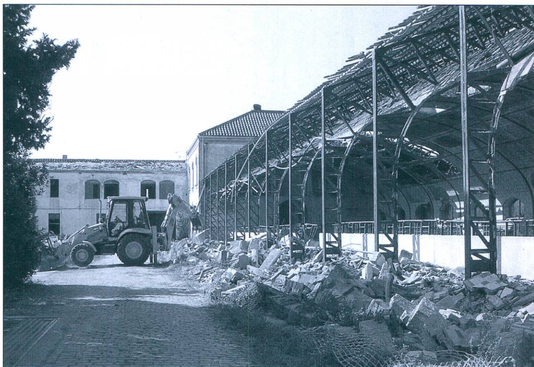
Las máquinas han dejado La Ricarda reducida a escombros
