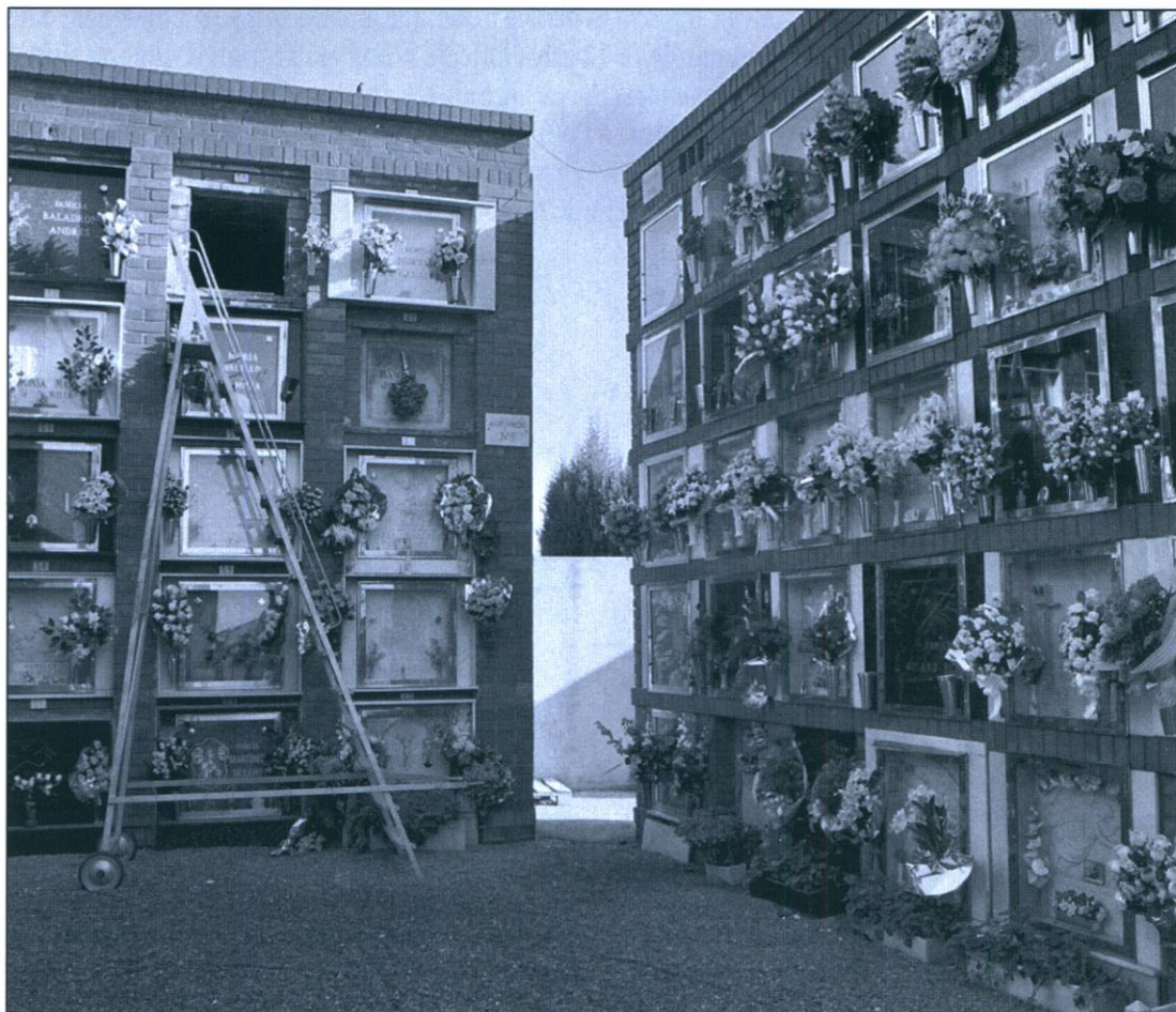
Los visitantes se quejan de que el óxido de la escalera mancha los nichos inferiores
