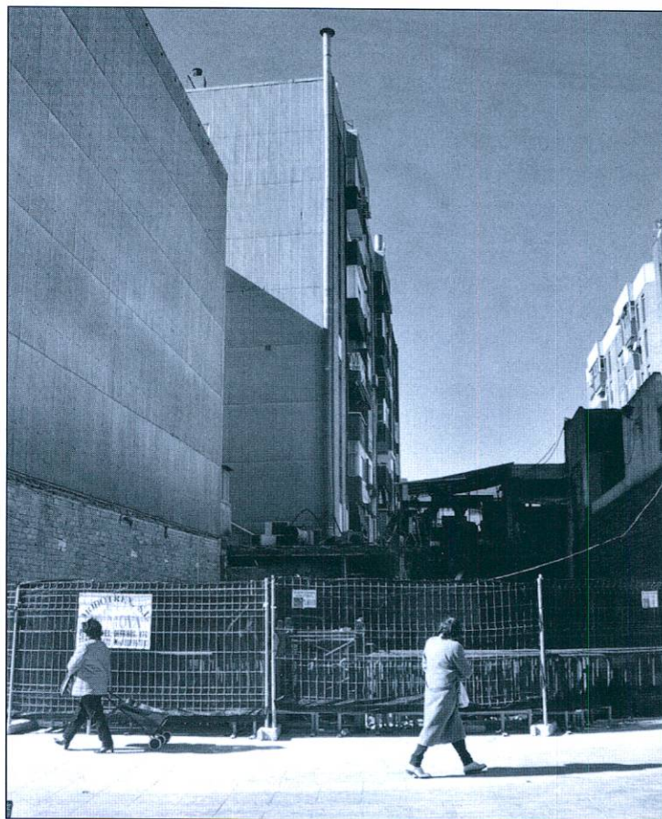
Espacio de 'La Zonilla' destinado a la construcción de pisos
