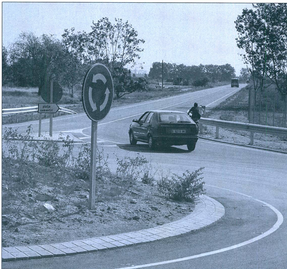
Las glorietas pueden inducir a error en algunas ocasiones
