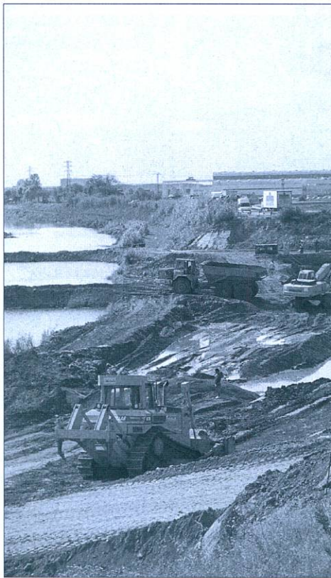
Les obres de desviament del riu han provocat l'intrusió marina.
