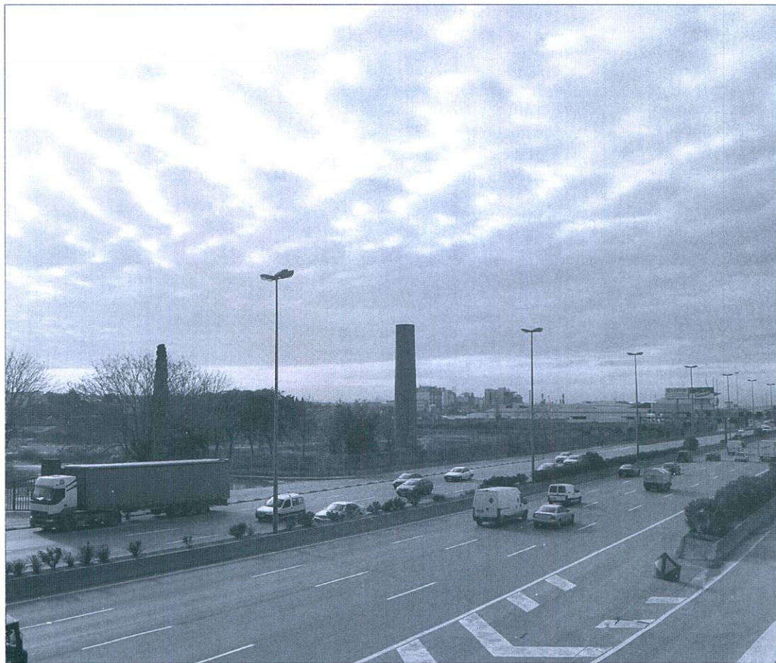
La muntanya artificial que cobrirà l'autovia s'estendrà des de la prolongació del carrer Joan Maragall i fins al pont de Ca l'Alaia
