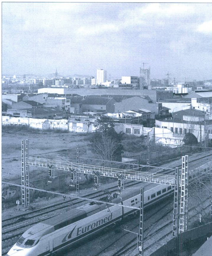
Al fondo, el barrio afectado por el AVE y el proyecto de elevación.
