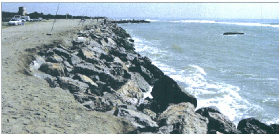
L'escullera avança per tota la platja. Força metres dintre de l'aigua s'observa les restes d'un búnquer de la Guerra Civil que es construí en terra ferma, lluny de les ones, com la dutxa que es veu flotar.
