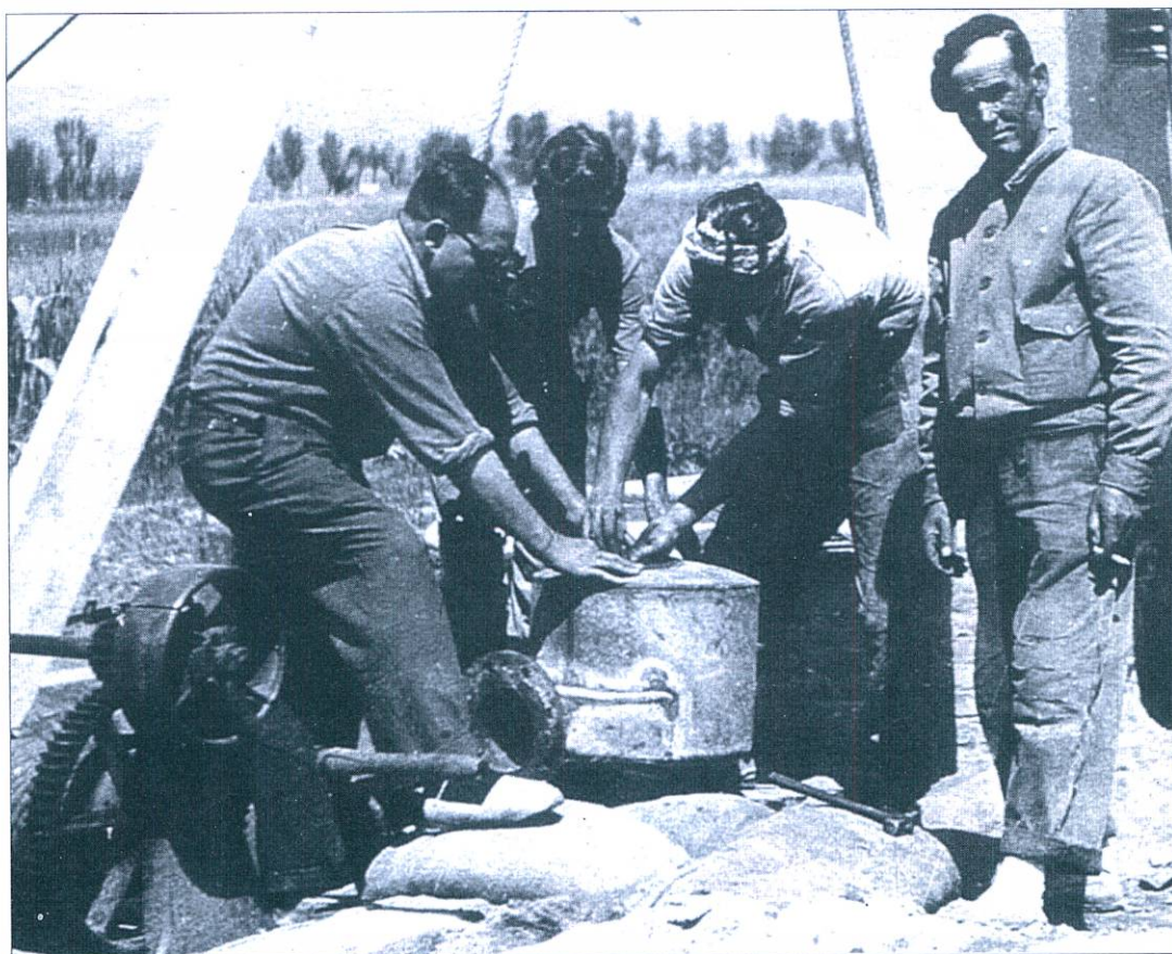
Treballs d'instal·lació del sistema de captació d'aigua en un pou artesià en l'arrossar «Cal Cubano» a principis del anys cinquanta.
