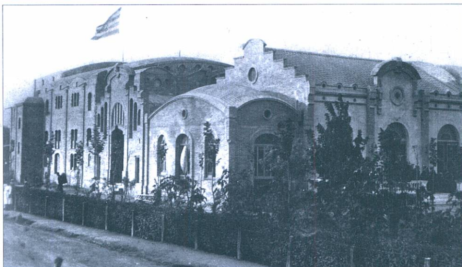
Un gran equipament inaugurat al 1919, que denota l'inspiració del Modernisme.
