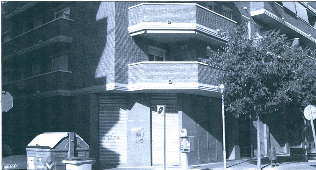
Als baixos d'aquest edifici del carrer Centre s'ha d'inaugurar l'hotel d'entitats
