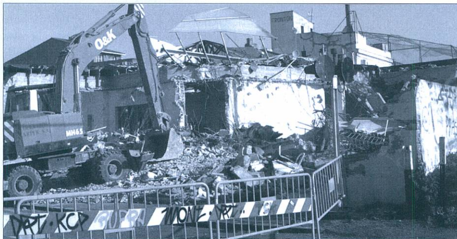
Les excavadores ja han començat canviar el paisatge del Prat Nord.
