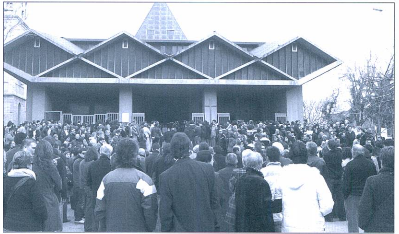
La plaça i l'interior de l'església van quedar petits per la mostra de dol massiva
