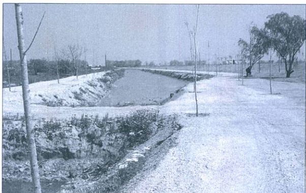
El canal de trasvassament, ara acondicionat com a zona de descans
