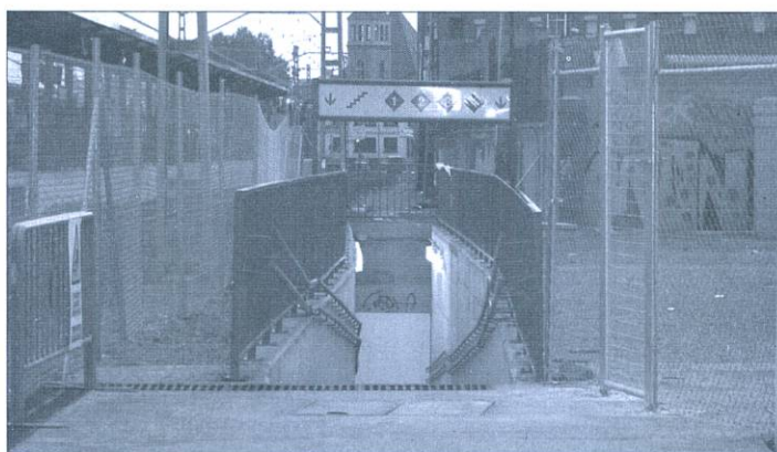
Les rampes suposen una millora respecte les escales de l'antiga estació
