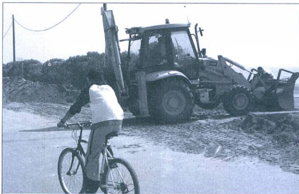
Les màquines treballen per acondicionar la futura zona de vianants
