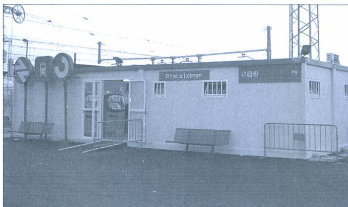
Mòdul principal de la nova estació provisional
