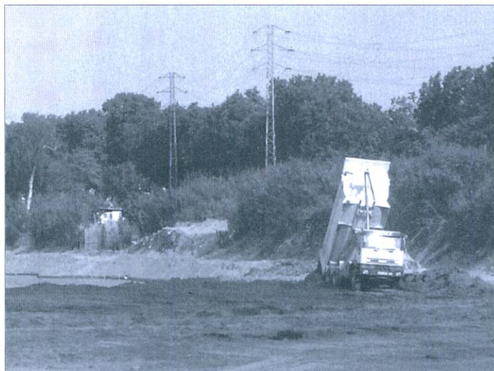
Los camiones descargan tierra continuamente sobre la nueva laguna en que ha quedado convertido el antiguo cauce del Llobregat
