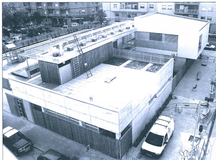
Vista de la nova escola bressol.
