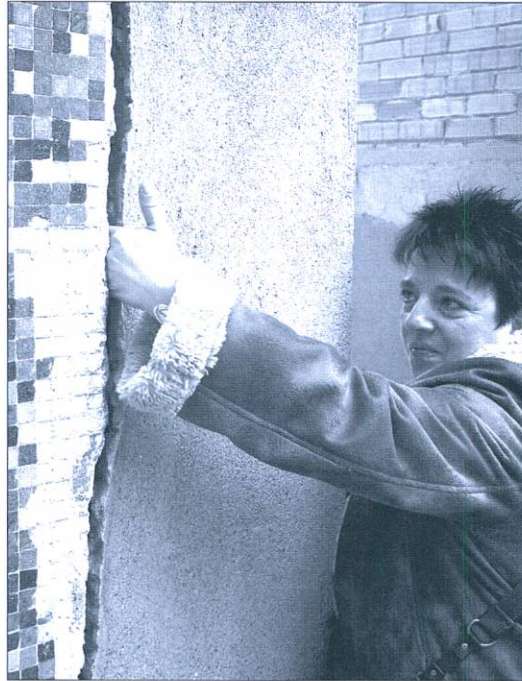
A l'esquerra, comprovant com en algunes esquerdes s'hi pot ficar gairebé la mà sencera. També, a la foto superior, es pot veure com les esquerdes d'algunes voreres es prolonguen desenes de metres
