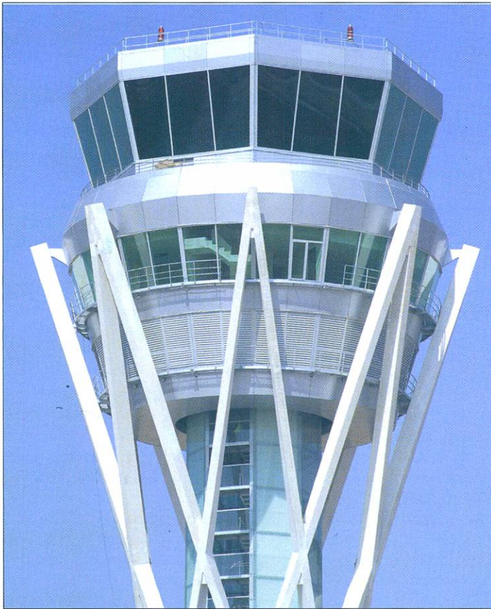
Vista exterior de la nueva torre de control de El Prat
