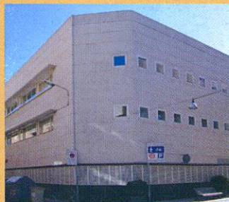
Oficines carrer Centre
