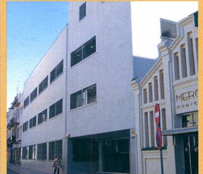
Oficines del carrer Major
