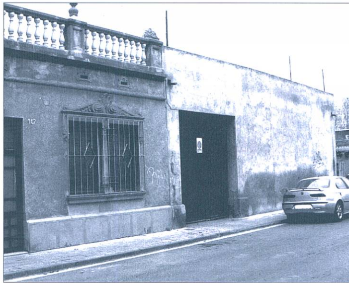
Façana de la casa i el garatge de la Pepita Prieto, al carrer Tarragona
