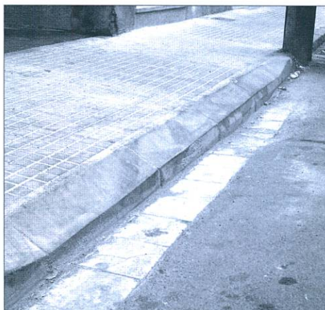
L'escàs pendent de la vorada fa perillar els baixos dels vehicles.
