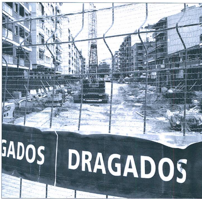
Obres a l'Avinguda Montserrat.
