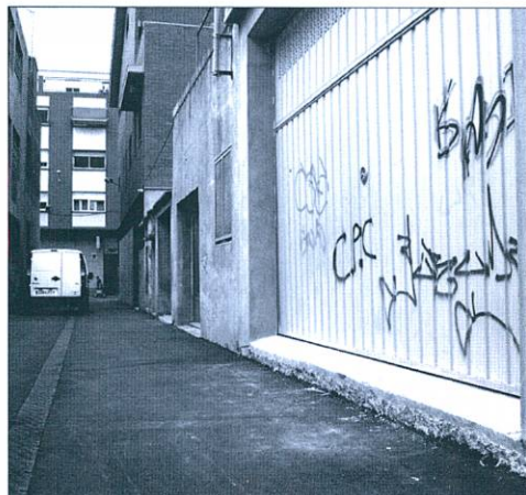
Accés impossible a un dels garatges del passatge del Penedés
