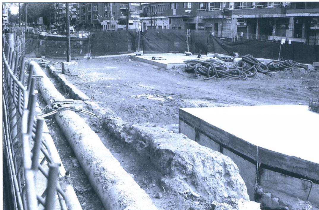
Obres de l'aparcament subterrani a l'avinguda Verge de Montserrat
