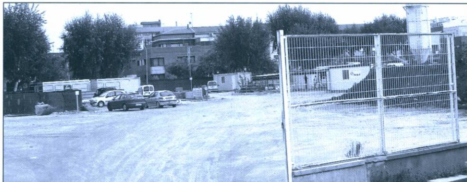
Estat actual de les obres sobre el camp de futbol del Fondo d'en Peixo
