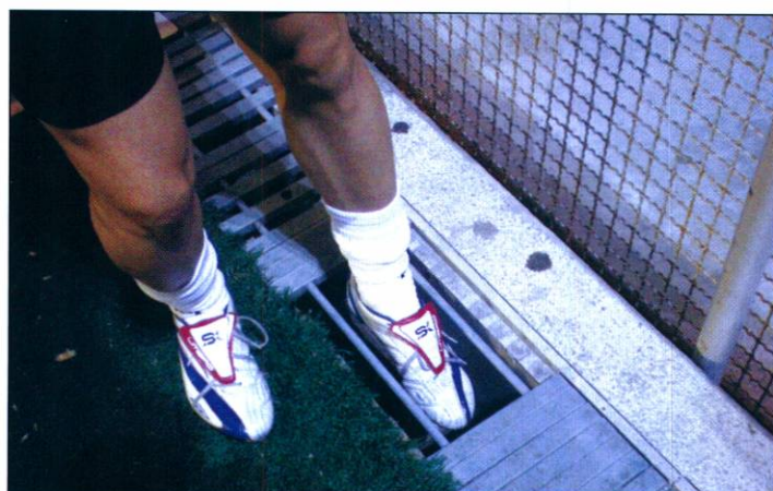
Las rejillas rotas de los desagües del campo pueden provocar lesiones
