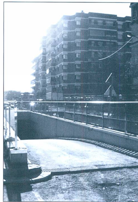
Les obres de l'Avinguda Verge de Montserrat estan a punt d'acabar
